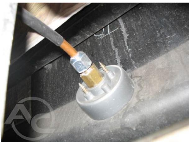
**Fotografía 1.3.3** Vista interior de la válvula de llenado
